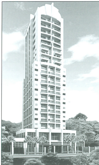
Slika 15: Green Philosophy, stanovanjska zgradba (2002), São Paulo. (vir: Cyrela).
