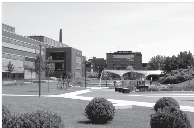
Slika 3: Park Graphisoft v severnem delu Budimpešte, ki ponuja sodobno delovno okolje in visokokakovostne storitve (foto: Tamás Egedy).
