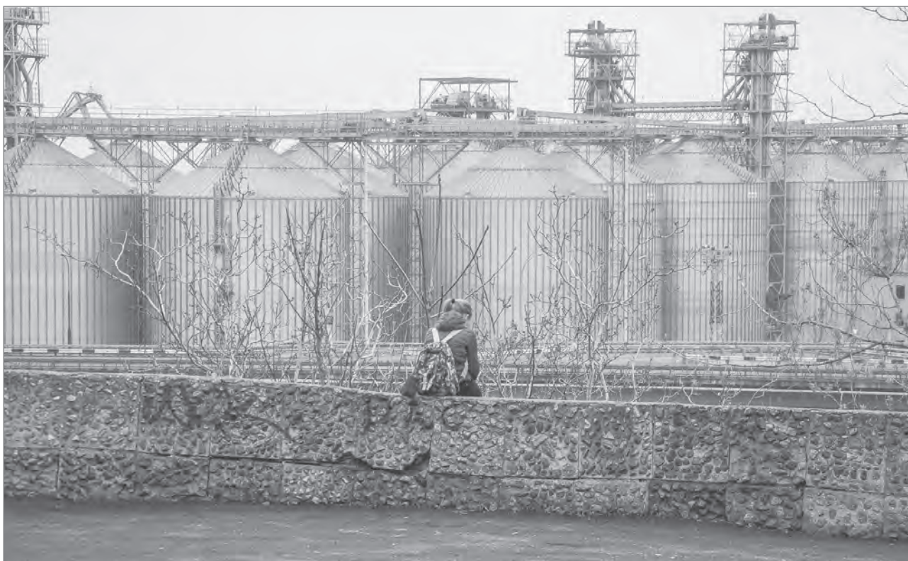
Slika 6: Gradnja terminalov za žito v središču Odesi (foto: Stanislav Gref)
