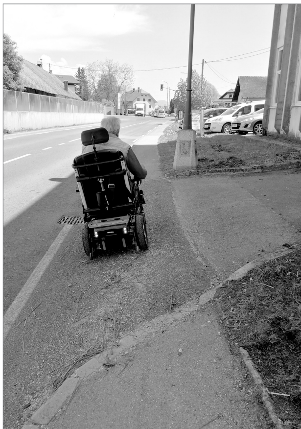
Slika 6: Pločnik, nagnjen proti cestišču v naselju Moste (foto: Ženja Brezovar).
