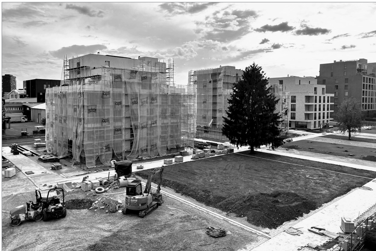
Slika 3: Gradnja novih stanovanjskih blokov ob Flajšmanovi ulici (foto: Ana Rožman)
