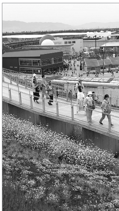
Slika 4: Veliki obroč (ang. Grand ring ) je krožna lesena konstrukcija, zgrajena z uporabo tradicionalnih japonskih tehnik gradnje z lesom. S svojimi 20 metri v višino in obsegom približno 2 kilometra je zasnovana po zamisli japonskega arhitekta Souja Fujimota. Simbolizira koncept enotnosti v raznolikosti, obiskovalcem pa ponuja sprehajalno pot z razgledi na razstavišče, morje in mesto, obdano s cvetličnimi gredicami in parkovnimi ureditvami (foto: Matej Nikšič).
