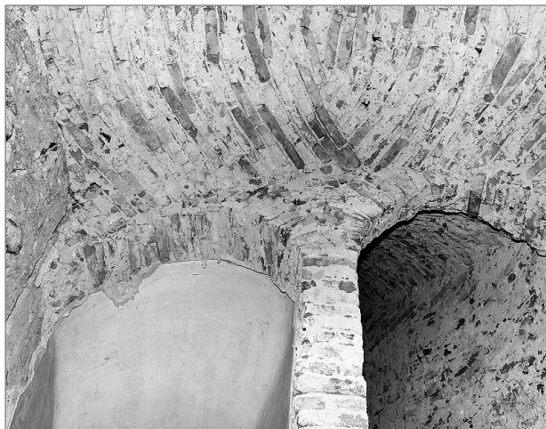
Slika 6: Nedovoljen poseg – uničenje starih ometov (vir: Grobovšek, 2010)
