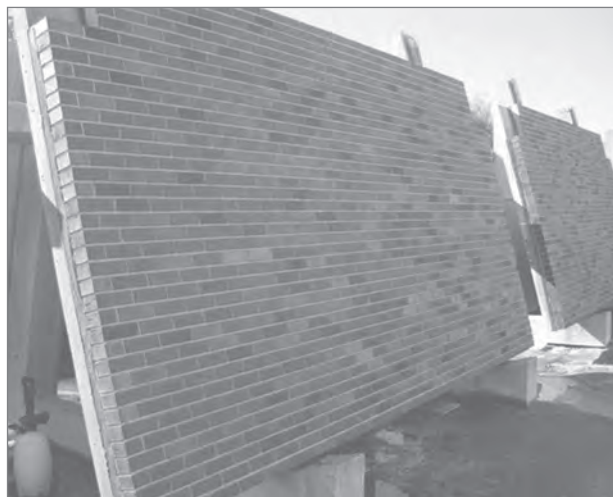
Slika 4: »Sendvičzidovi«, pripravljene za gradnjo (foto: internet 11).
