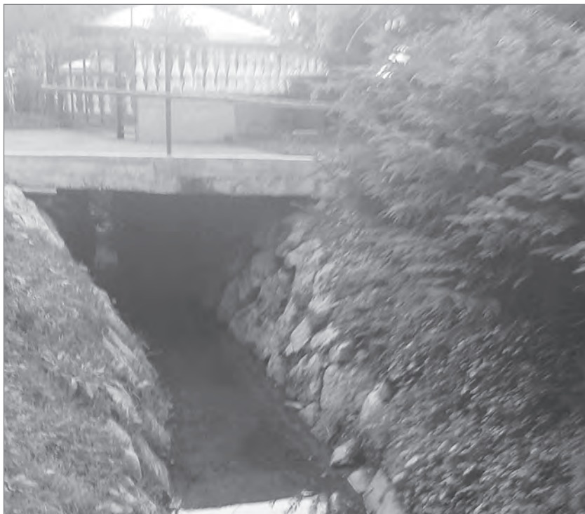
Slika 4: Nov most z večjim prepustom na dovozu do hiše z garažo (foto: Andrej Ciuha)
