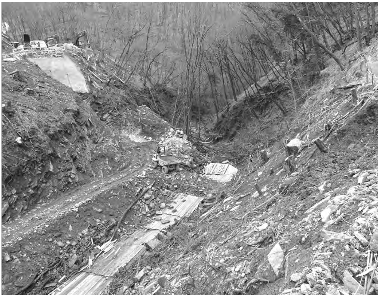
Slika 5: Fizična zaščita struge Glinščice (lesena bariera) pred gradnjo viadukta (foto: Arhiv ZRSVN, Območna enota Nova Gorica, 8. 1. 2021)
